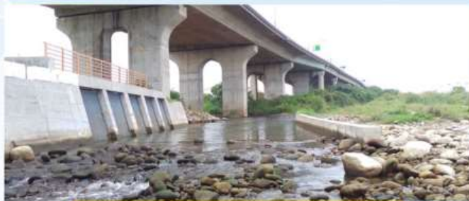
後龍圳導水路改善工程 工地位置：苗栗縣頭屋鄉
