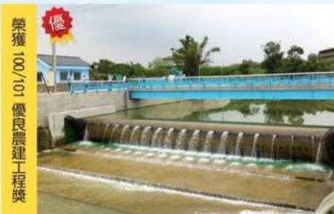
番仔圳制排水閘門等改善工程
