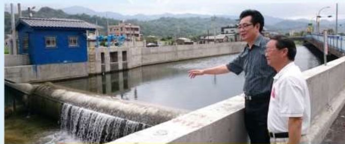
大份埤攔水堰改善工程 工地位置：苗栗縣公館鄉
