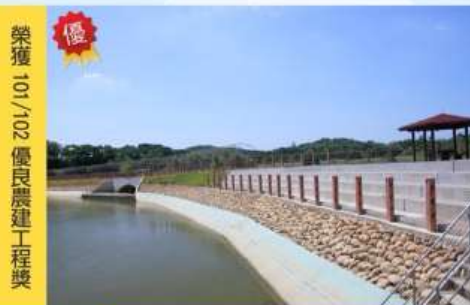
大潭調整池邊坡整治改善工程
