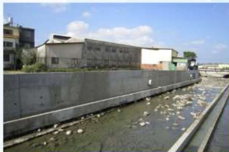
東河攔水堰護岸等改善工程
